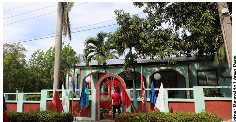
La Casa del Trabajador Azucarero luce ahora mayor confort.
